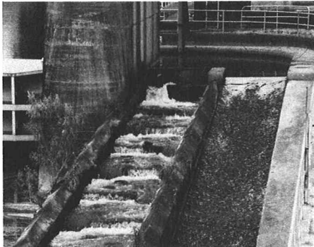
写真-3 最上流部にバーチカルスロットを挿入
