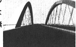
② 上部工、ライズ及びアーチ曲線の検討；本橋はダブルデッキで、かつそのアプローチが高架で連続しているため、一般的なアーチライズ（支間の1/6～1/8程度）、及びその曲線（放物線）の考え方は本橋に適用できないと判断し、独自に景観・構造・経済的な検討を行った結果、あらゆる視点からランドマークになると共にバランスの良いライズ高さ（f=32m）、及び広がりのある周辺景観に適したのびやかで親しみを感じさせる単円をアーチ軸線に採用した。
