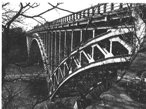
a) 昭和初期に架設されたアーチ橋
