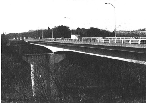
b) 昭和50年代に架設された桁橋(片側供用) 写真-1 参考とした橋梁
