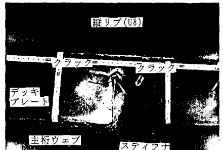
写真-2 Case2のクラック発生状況(いずれも下から見上げた写真)
