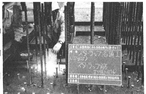
図-2 ずれ止めの打設状況
