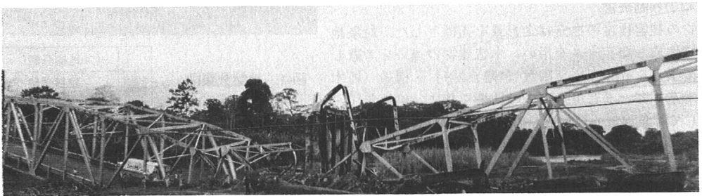
写真3 Estrella川に架かるトラス橋の被害
