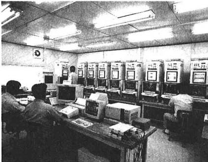
写真－2 グラウチング管理室
