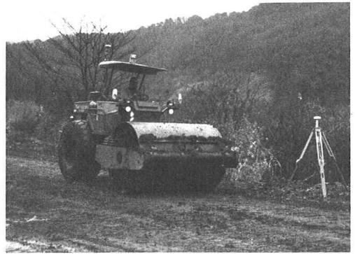
写真-1 振動ローラーによる走行実験
