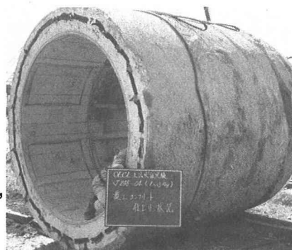
写真-1 覆工コンクリート
