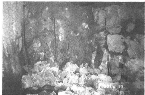
写真-2 2次破碎後の状況
