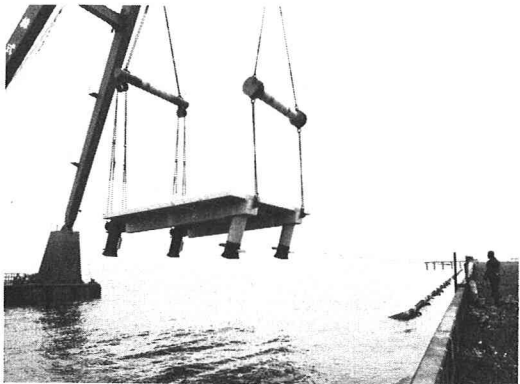
写真－2 施工状況 (SRC傾斜板据え付け)
