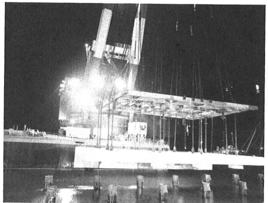
写真-1 プレキャスト床版設置状況
