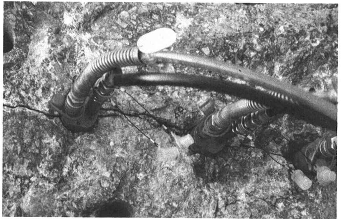
写真-1 き裂拡幅状況
