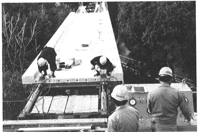
写真-3 施工状況（2）
