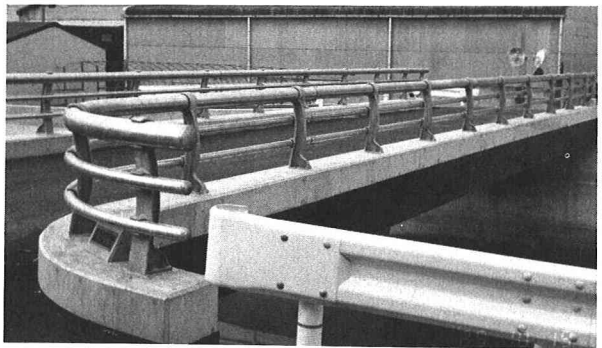
写真2 中谷橋（二等橋、支間24m、幅員5m）
