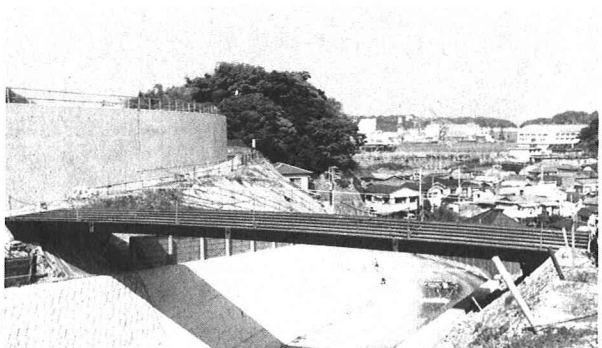
写真3 歩道橋（支間23.3m、幅員4.8m）
