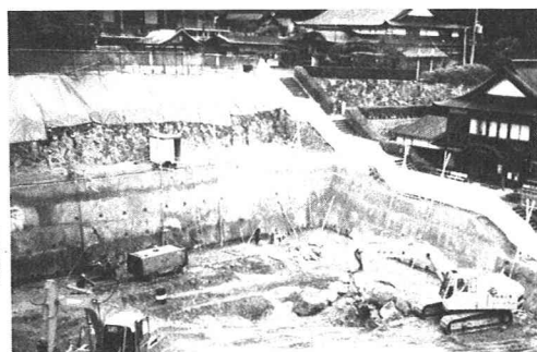
写真-1 掘削完了時の施工状況(施工例1)
