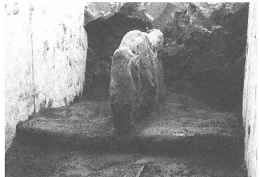
写真-1 造成された逆T型固結体
