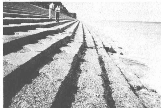
写真-3 青海海岸の緩傾斜堤の状況(中央東寄り)
