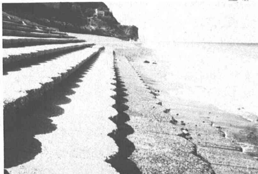
写真-2 青海海岸の緩傾斜堤の状況(中央西寄り)
