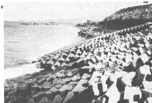
写真-4 青海海岸の緩傾斜堤の状況(東端)
