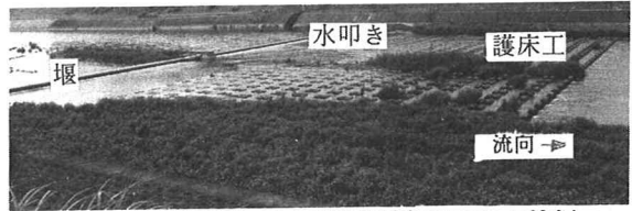
写真-1 観測地点（西脇井堰護床工）の流況
