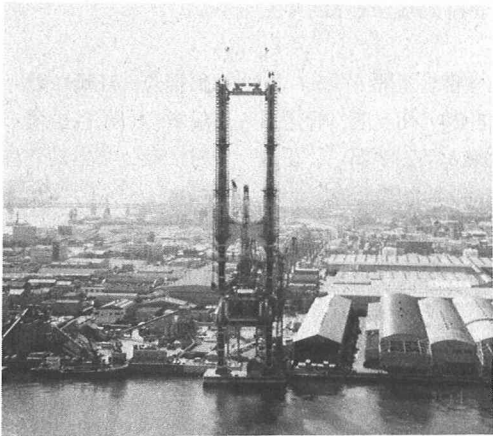
写真-1 主塔独立状態（H 3. 4 撮影）
