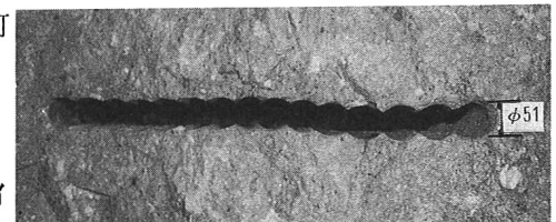
写真-3 形成スロットの状況
