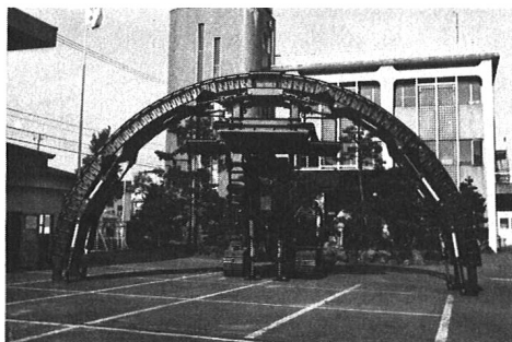
写真-2 型枠セット状態
