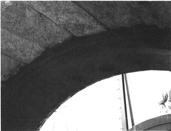
写真－2 脱型した覆工体
