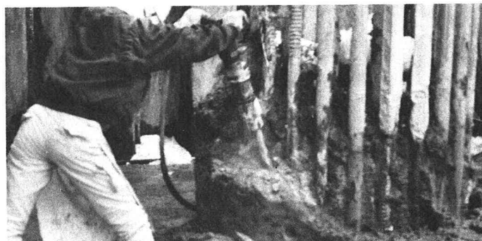
写真-4 ブレーカ使用状況
