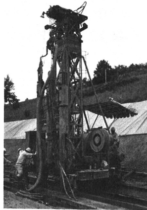
写真-1 掘削状況
