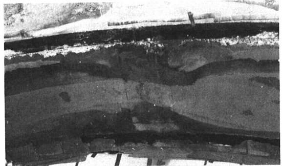
写真-2 天端付近出来形
