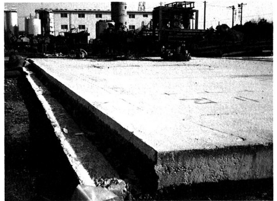
写真-1 端部の破砕状況
