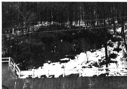
写真 測定箇所の状況
