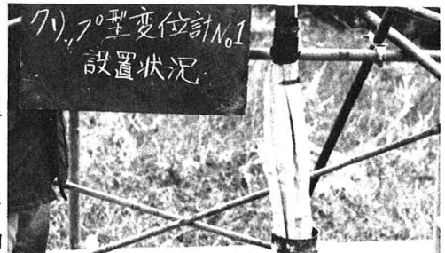
写真-1 クリップ型変位計取付状況
