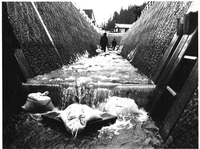
写真1 実験箇所の河道と堰の状況(1990年2月27日撮影)
