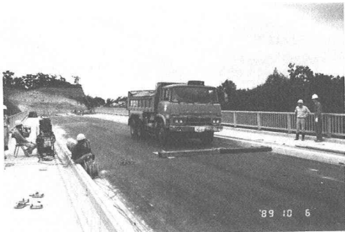
写真-1 車両衝撃加振の状況
