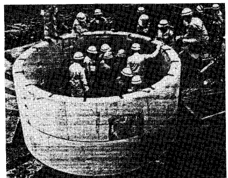
図-6 水平仮組試験状況
