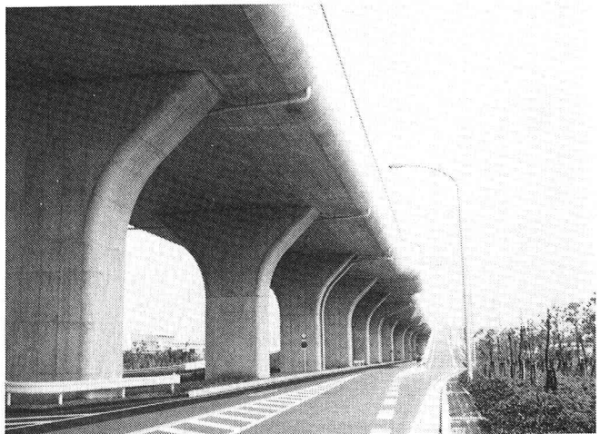
写真-1 PC連続中空床版ラーメン橋
