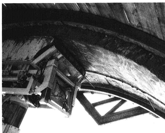
写真-2 模擬トンネルによる覆工実験状況
