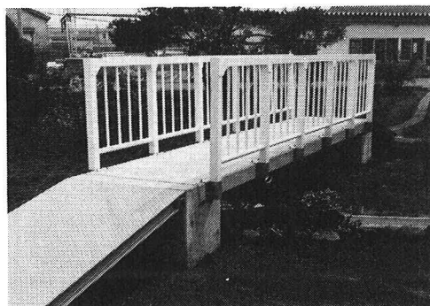
図-7 PC床版歩道橋
