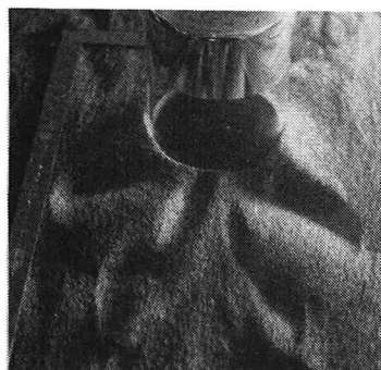
写真-1 ツノ状洗掘 上：沖側，下：岸側
