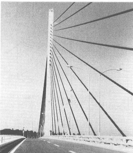
写真-2 ドライバーから 見た中央分離帯 内のダンパー
