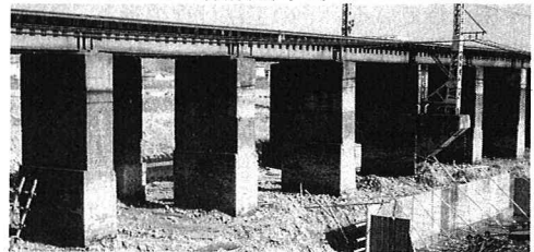
写真-2 根固め・補強完成
