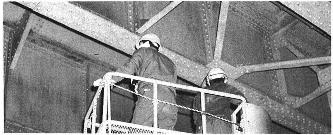
写真 バックル・プレートの現状調査
