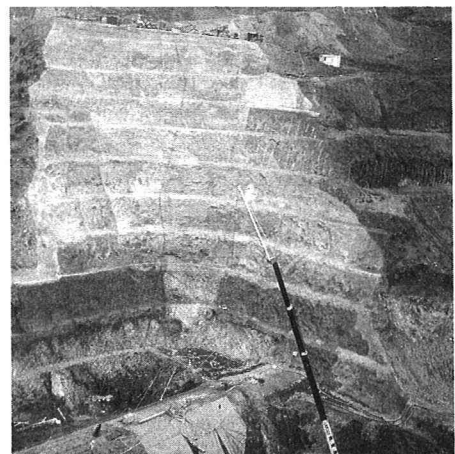
写真-2 法面掘削完了
