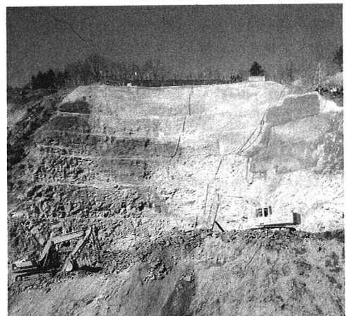
写真-1 施工状況
