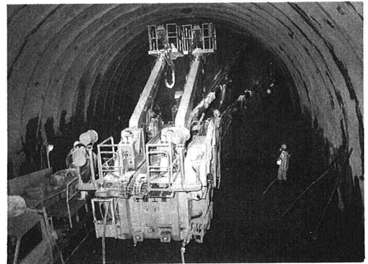
写真-1 発破孔ロックボルト孔の並行削孔
