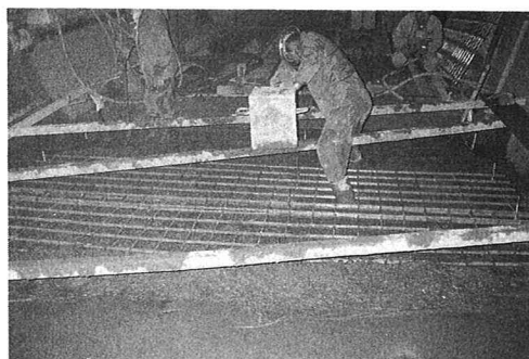
図-3 インバート筋の取付け状況 ②
