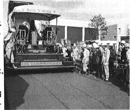
写真-I 敷き均し状況
