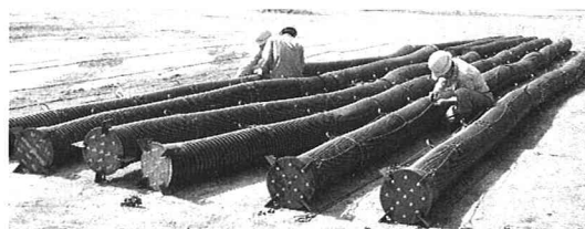
図-2 集水管の構造
