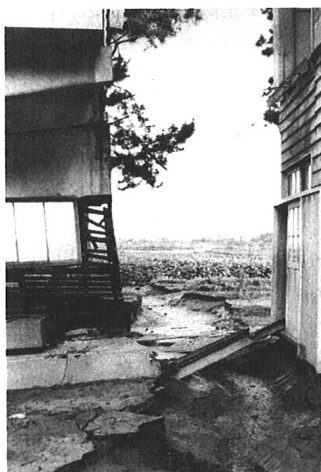
写真3 H-I校舎渡り廊下
