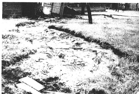
写真2 小学校校庭の亀裂
