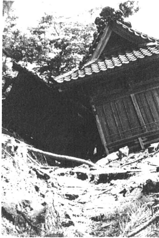
写真1 亀裂に落ちた社
