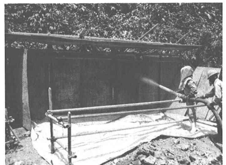
図-5 坑外施工試験の状況
