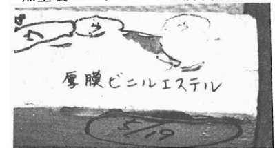
写真-2 厚膜ビニルエステル劣化状況
