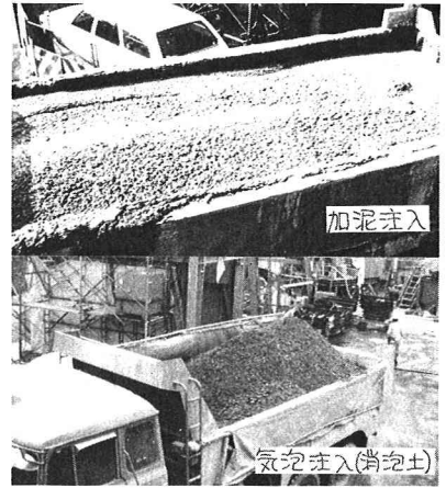
写真3 ダンプへの積込状況
