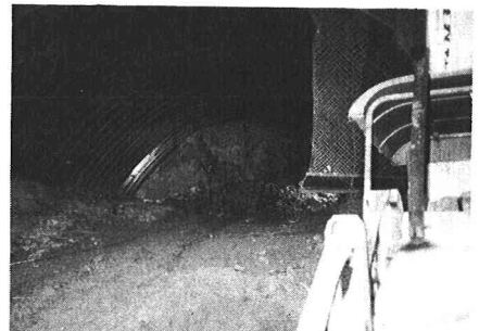
トンネル上半部
